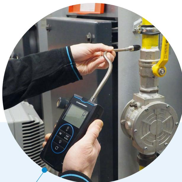
Pour la détection de la plupart des fuites de gaz réfrigérant dans le circuit de gaz d'une pompe à chaleur.
