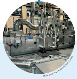
连续监测空气处理系统(AHU) 通风管道中 的CO2浓度。
