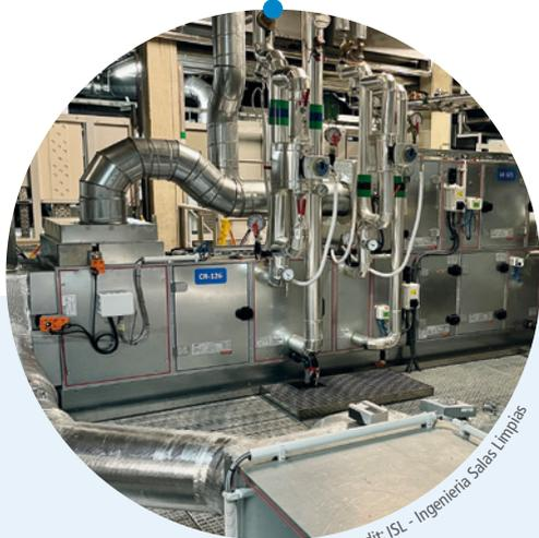
Surveillance constante de la concentration en CO<sub>2</sub> de l'air dans un conduit de ventilation en sortie d'une centrale de traitement d'air.
