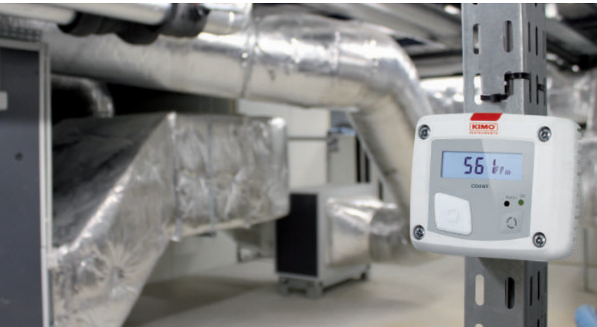
安装在工业设备的空气处理装置中的 CO2ST
