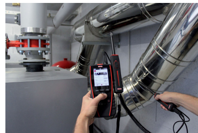
Medición de higrometría y caudal de aire
