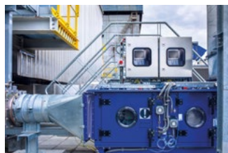
Regolazione dinamica pressione/psicrometria/temperatura/portata aria/TRA** in unità di trattamento dell'aria e canalizzazioni.
