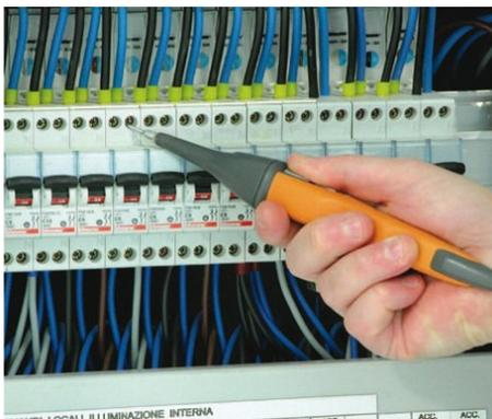
La sonde déportée (accessoire optionnel PR400) permettant de lancer une mesure
