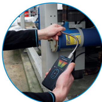
检测制冷设备中的冷媒泄漏
